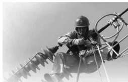
工人穿戴工作服进行超高压带电作业
